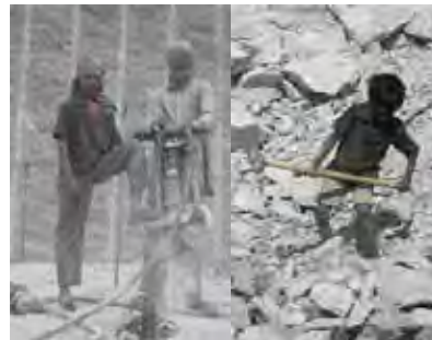
junge Arbeiter mit Pressluft- und mit mechanischem Hammer!
